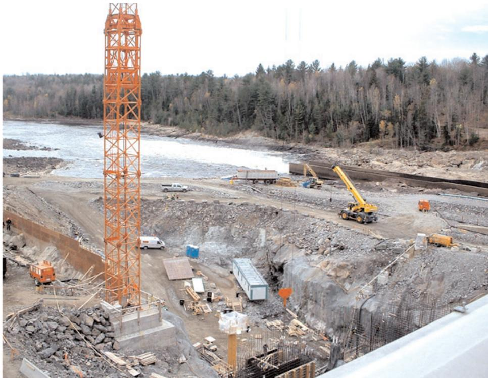
Une partie du réservoir Baskatong a été asséchée pour les travaux de bétonnage.
