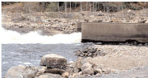
Une pression d'eau de 150 mètres cubes/secondes sort du barrage dans le moment. Elle sera du double lorsque la centrale sera en fonction
