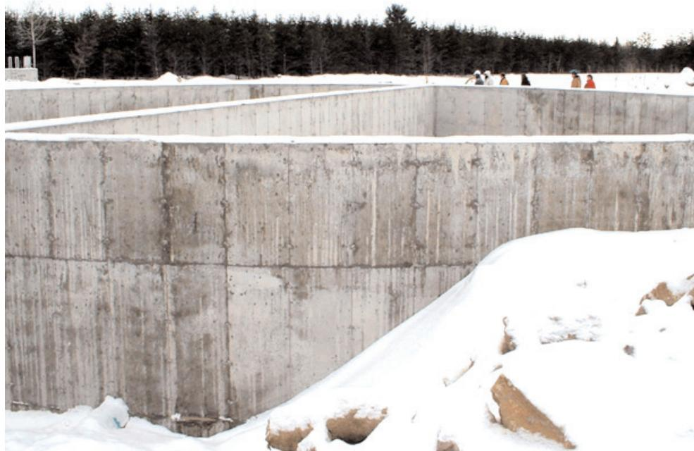
La construction des étangs aérés est terminée. Ceux-ci seront munis de sept aérateurs injectant de l'air dans l'eau. La hauteur d'eau dans ces étangs sera de 3,5 mètres et le volume utile de 3 166 mètres cubes.
