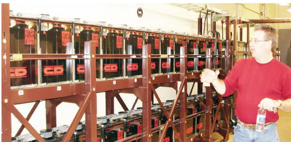
Le technicien de Bell Aliant à Maniwaki présente les batteries qui permettent au réseau téléphonique de continuer de fonctionner lors d'une panne d'électricité.
