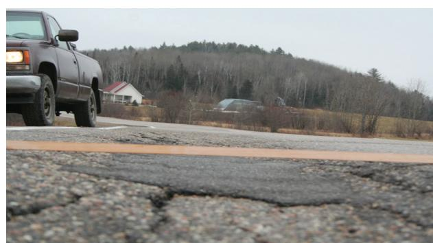
À la hauteur du lac Lannigan, en direction des Quatre-Fourches, au beau milieu de la voie de droite, le conducteur roule sur une surface qui s'est enfoncee d'environ 6 pouces. Une planchette de bois placée au dessus donne idée de la profondeur de l'ornière non réparée depuis au moins deux ans.
