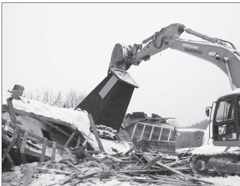
Les travaux de démolition ont été confiés à l'entrepreneur local Les Carrières Clément Tremblay et Fils.
