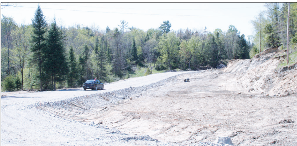
Les travaux de construction du chemin principal et de ses bretelles seront complétés d'ici un mois.
