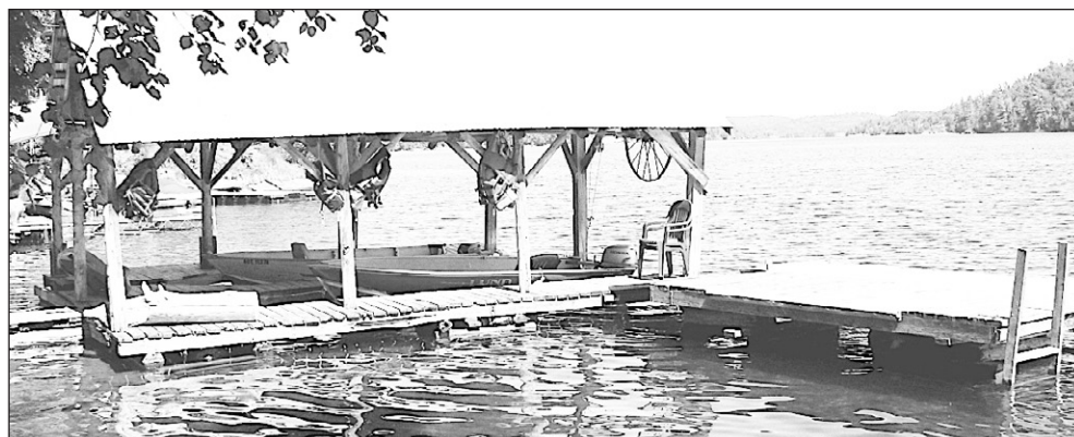
M. Isabelle a construit son abri de bateaux, qu'il partage avec un voisin, en 1968. «Les travaux de rénovation sont tellement minimes que je m'explique mal le fait que je ne puisse les faire.»
