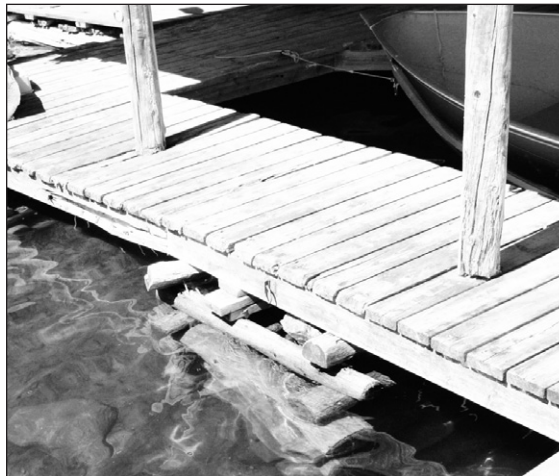
Les glaces hivernales ont légèrement déplacé le tablier de l'abri de bateau. Comme vous pouvez le voir, la rénovation est mineure.
