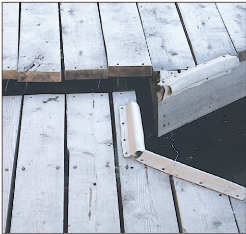
La rénovation est simple : un raccordement de ces deux segments du tablier est un jeu d'enfant.
