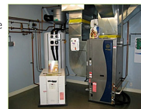
La salle mécanique
