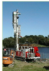
La foreuse Comacchio MC 900 GT en opération
