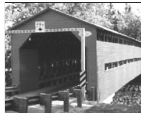
Le pont de rivière de l'Aigle à Egan-Sud.
