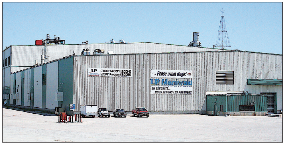
L'usine Louisiana Pacific sur le chemin du parc industriel à Bois-Franc dont les travaux de réfection du chemin qui y donne accès débuteront sous peu.
