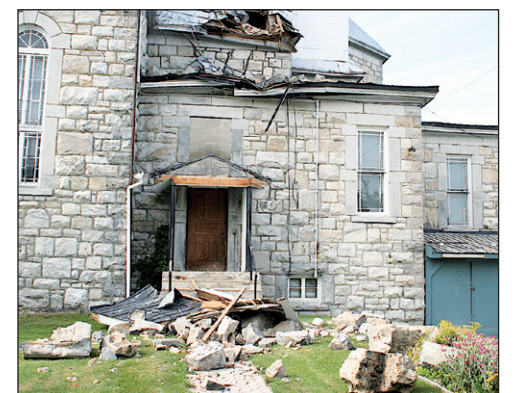
La paroisse de Gracefield a besoin de 50 000 $ pour réaliser les travaux de rénovation à la suite du tremblement de terre du mercredi 23 juin dernier.
