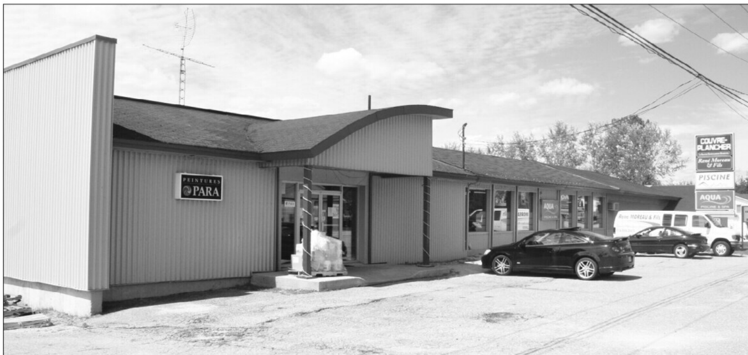
La Gatineau occupera la portion nord de l'édifice René-Guy Moreau et Fils. La portion sud a été louée au vendeur, en fonction d'un bail de cinq ans.
