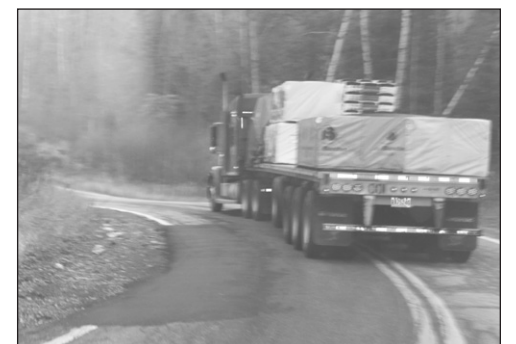
Cette photo donne raison à ceux qui insistent sur le fait que la portion non finalisée de la route 107, en territoire d'Antoine-Labelle est inadéquate au transport moderne et s'avère dangereuse. Ici un long transporteur doit négocier bien à gauche un détour situé au dessus d'une dénivellée inacceptable qui coupe dramatiquement le champ de vision.
