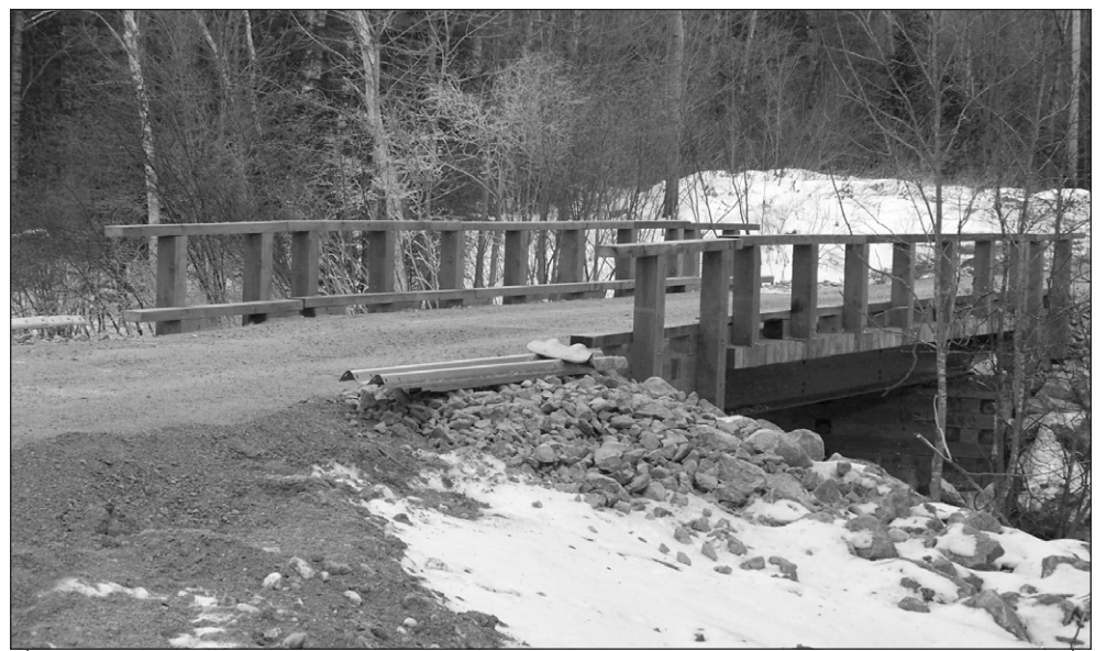
Il ne reste plus que les glissières à ajouter au pont du Lac Logue. Photo : Alain Fortin
