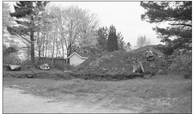
Des travaux d'excavation ont été effectués la semaine dernière sur le terrain où devrait être construite la nouvelle caserne des paramédics sur la rue Principale-Sud à Maniwaki.
