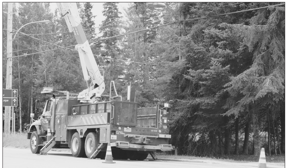
Le personnel d'Hydro-Québec a sillonné le territoire pour rétablir l'électricité.
