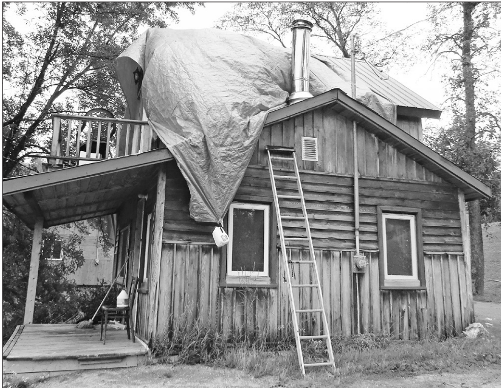
À la pourvoirie Whitefish, la toiture de ce chalet a été arrachée.
