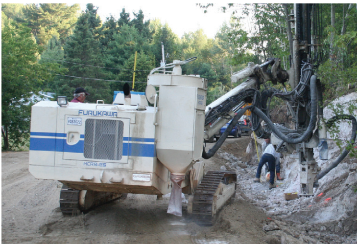
Dynamitage Ritchie compte sur des experts dans un domaine où l'entreprise oeuvre depuis plus d'un demi-siècle.
