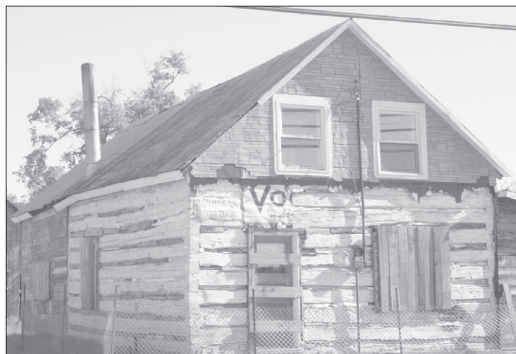
La Maison Chamberlain, et l'écurie que vous voyez en arrière-plan, seront relocalisées sur un terrain déjà aménagé derrière la bibliothèque municipale. Un contracteur, expert en cette matière, doit être embauché sous peu.
