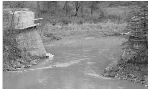
Les travaux de reconstruction du pont du Ruisseau Skag à Low, détruit lors du démantèlement de la voie ferrée il y a plus de 20 ans, sont en cours et devraient être complétés sous peu.
